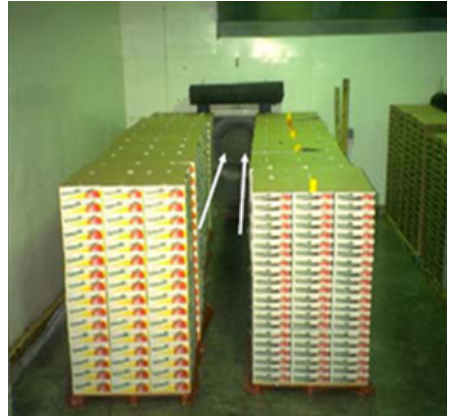
الصورة رقم 24: غرفة التبريد بدفع الهواء بعد وضع البضاعة وقيل فرد المشع
